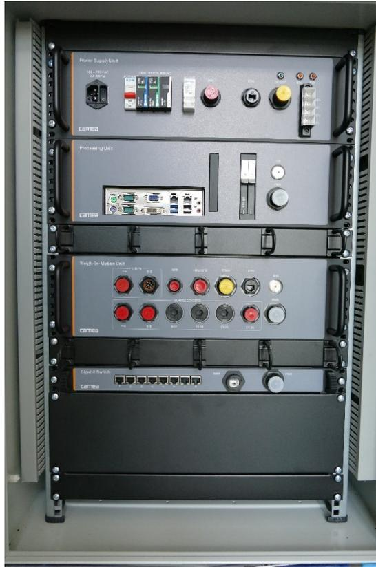
Рисунок 3 - Шкаф управления системы UnicomWIM с блоком обработки сигналов UC-WLU (пример)
