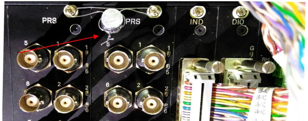
Рисунок 7 – Места пломбировки блоков обработки сигналов UC-WLU и UC-ZPU в шкафу управления
